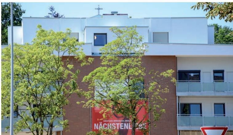
Blick auf die umgebaute Lebenskirche, die fast sieben Jahre nach ihrer Entwidmung als Seniorenzentrum eröffnet wurde.
